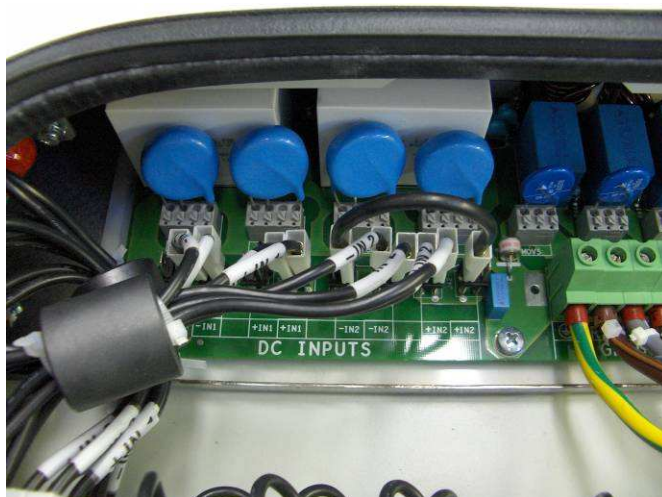
Fig.13 Nodige aansluitingen om de kortsluiting uit te voeren op kanaal 2
